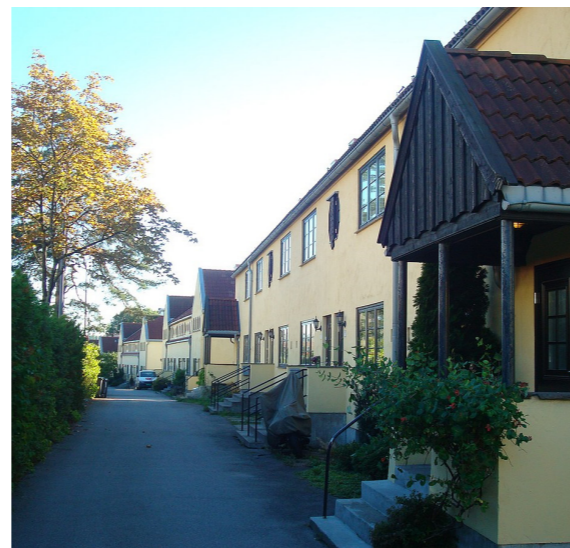
4. GRØNVOLL HAGEBY: Oppført i 1912 som arbeiderboliger for Nitedals Tændstikfabrikk
