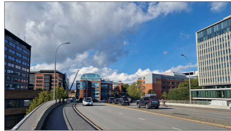
1. Broen over E6. Grenseveien med Fredrik Selmers vei 6 til høyre.
