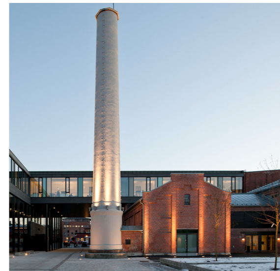
2 F21 SKOLE: Bevaringsverdig pipe og bygg fra fyrstikkfabrikken (1907-1940) er integrert i skoleanlegget.
