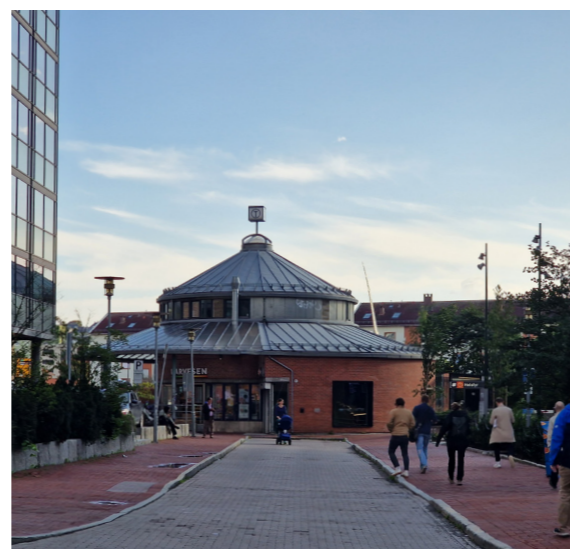
7. HELSFYR T-BANESTASJON: Særpreget stasjonshall bygget i 1966.
